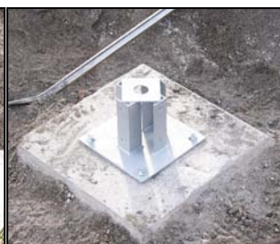
【写真5 腐朽した脚部と柱撤去後に金具を設置した様子】
