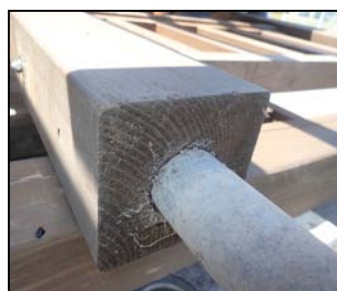
【写真22 トドマツ柱脚部】
