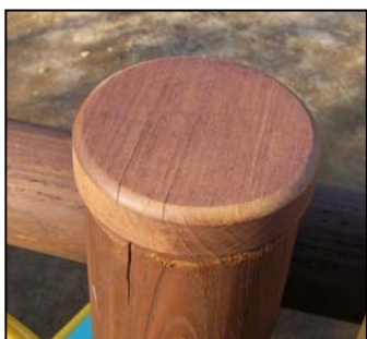
【写真8 柱頭の保護部材】
