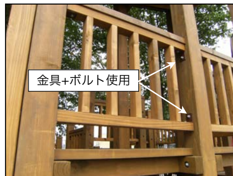
【写真16 金具を用いた手摺の取り付け】
