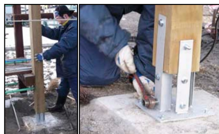
【写真6 柱を設置し平金物で固定】
