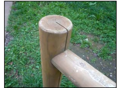
【写真14 支柱への手摺取付け事例】
