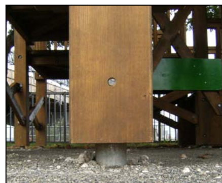
【写真3 埋め戻し後の様子】
