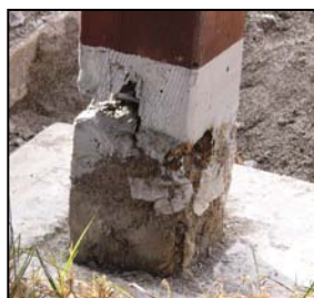
【写真5 腐朽した脚部と柱撤去後に金具を設置した様子】
