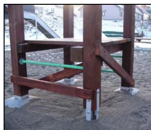
【写真7 補修終了後の様子】
