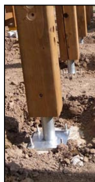
【写真2 施工の様子】
