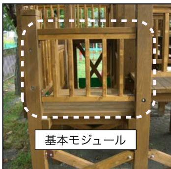
【写真15 手摺のユニット化】
