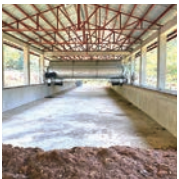
堆肥生産施設
