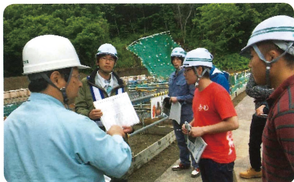
写真-1 砂防堰堤の施工現場の見学
